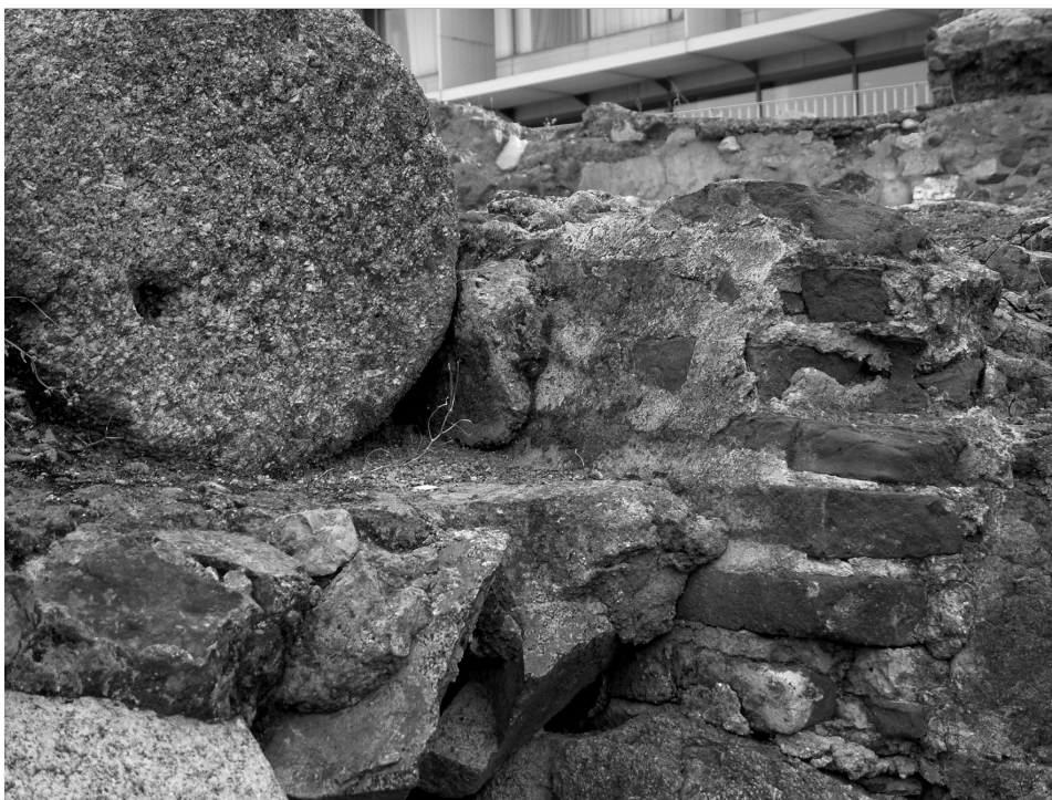
Fig. 2. Lienzo de reparación en opus testaceum en el tramo de muralla de Morería.
