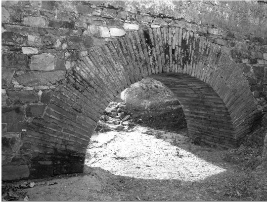
Fig. 20. Arco en opus testaceum en el interior de la casa del anfiteatro.
