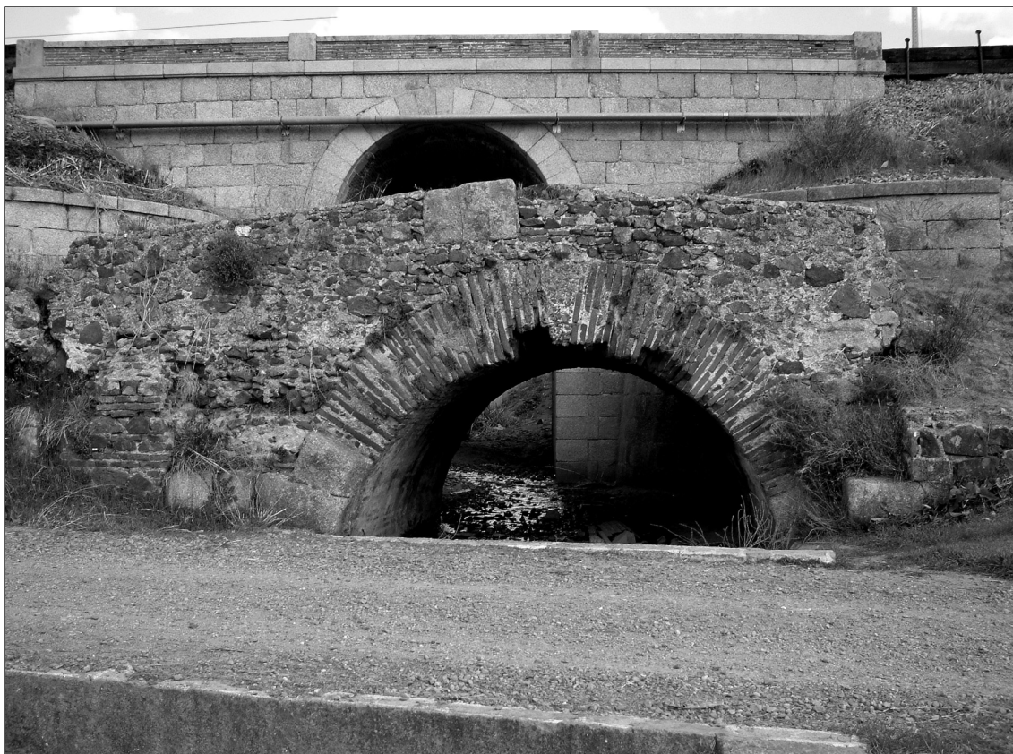
Fig. 13. Arco en opus testaceum en el puente de la Alcantarilla.
