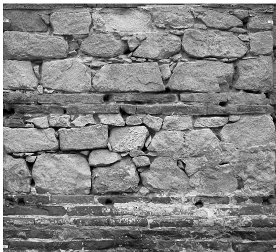
Fig. 9. Detalle del aparejo de los muros de delimitación del pórtico del foro en la calle Sagasta.
