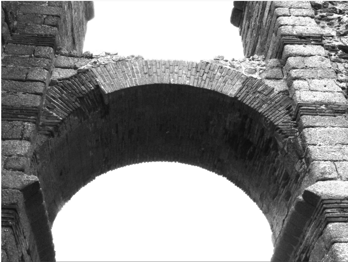
Fig. 17. Detalle de uno de los arcos de opus testaceum en los ordenes superiores del acueducto de los Milagros en el valle del Albarregas.
