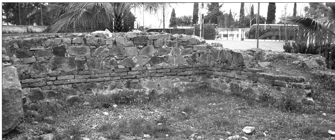
Fig. 25. Estructura cuadrangular en el interior del colegio Giner de los Ríos.
