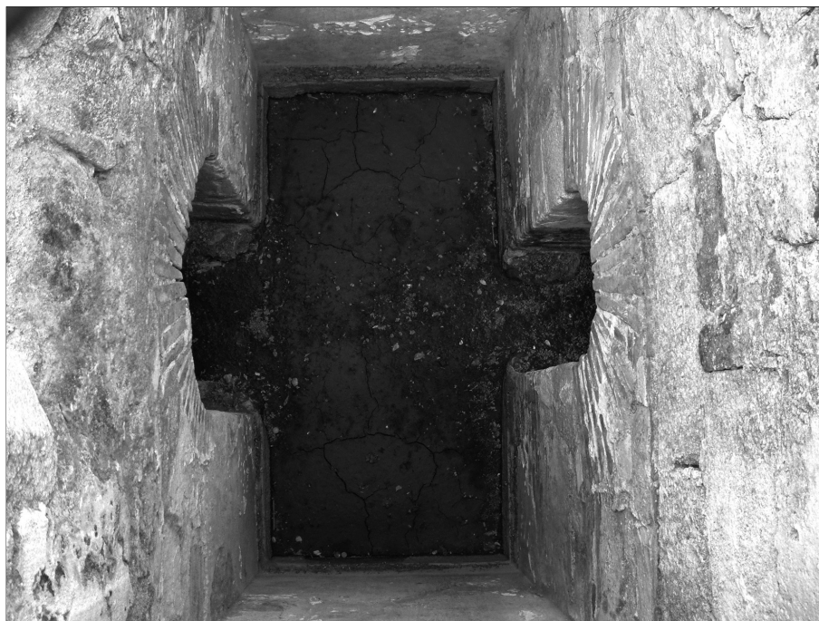
Fig. 23. Arcos de las canalizaciones de entrada y salida de la piscina limaria situada en el interior de la casa del anfiteatro.
