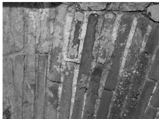
Fig. 22. Detalle del acabado del mortero en el aparejo anterior.
