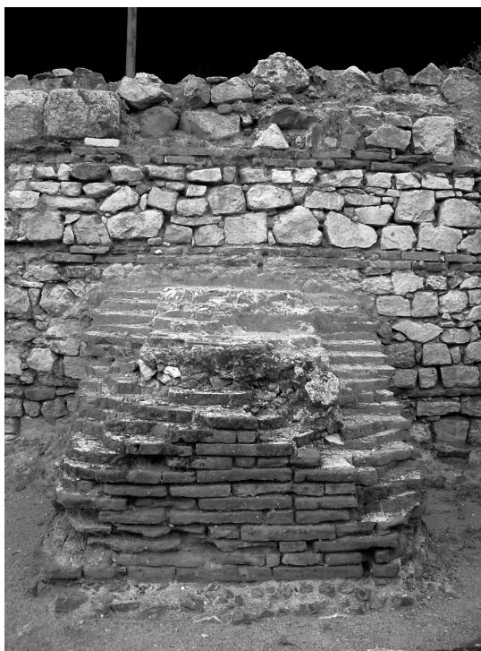
Fig. 10. Detalle del aparejo de uno de los basamentos situados en el interior de las habitaciones noreste del pórtico del foro.
