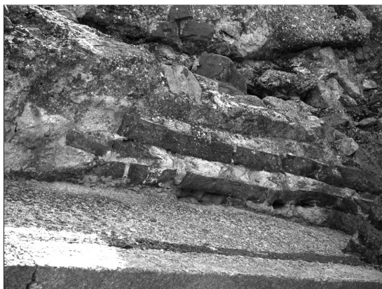
Fig. 26. Detalle de los arranques de las bóvedas que cubrían los vomitorios de acceso a media y summa cavea del teatro.
