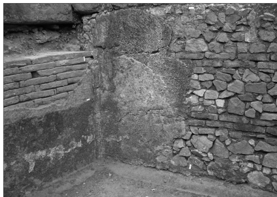
Fig. 5. Zona suroeste del estanque oriental del templo de Diana con las distintas intervenciones constructivas que emplean opus testaceum .
