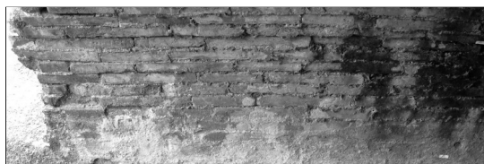
Fig. 14. Detalle del aparejo de la bóveda del arco en el puente de la Alcantarilla.
