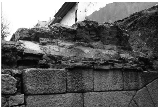
Fig. 12. Detalle de los arranques de las bóvedas.
