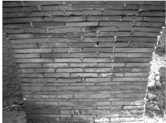
Fig. 21. Detalle del aparejo de la bóveda del arco en el interior de la casa del anfiteatro.
