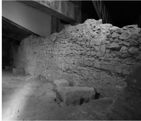
Fig. 8. Vista general de la estructura de delimitación en la zona sur del recinto del Centro Cultural Alcazaba.
