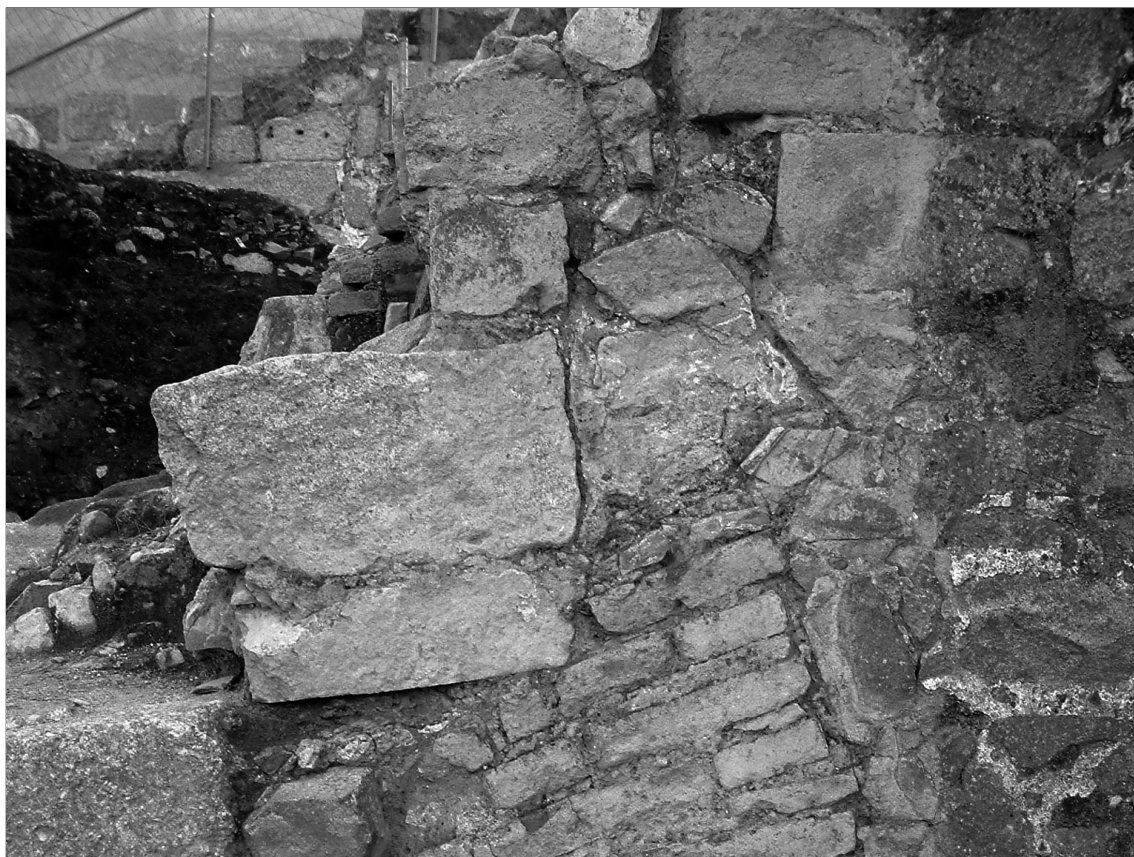
Fig. 1. Arranque del arco perteneciente a un portillo de acceso a la ciudad en el tramo de muralla del Alcazaba.
