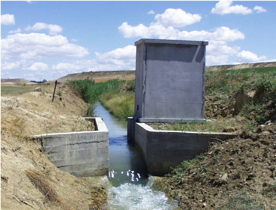
Estación de aforo y calidad
